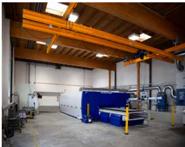
Die Laser - Multifunktions - Anlage in der umweltfreundlich, komplett renovierten Fabrikhalle. Die Prozesswärme und Abluft wird über eine moderne Filteranlage als Heizluft in den Betrieb rückgeführt.
